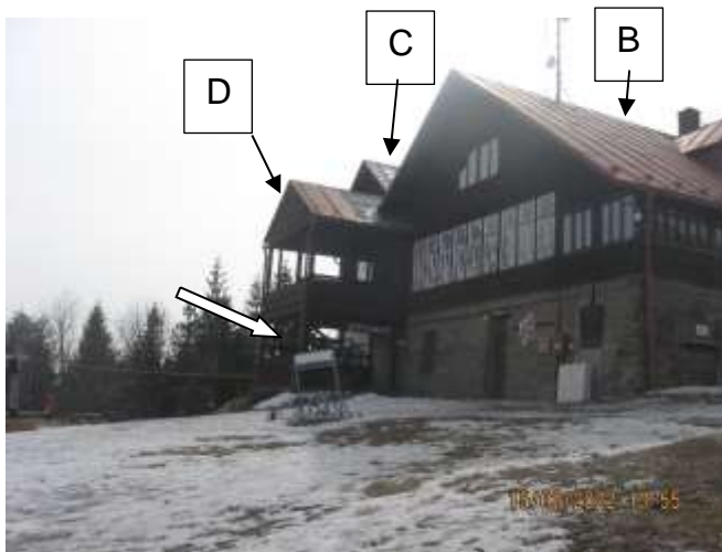
pohled na venkovní přístavbu zastřešeného schodiště k hlavnímu vstupu – ocelová knstrukce s dřevěným obkladem (2002 – 2003)
