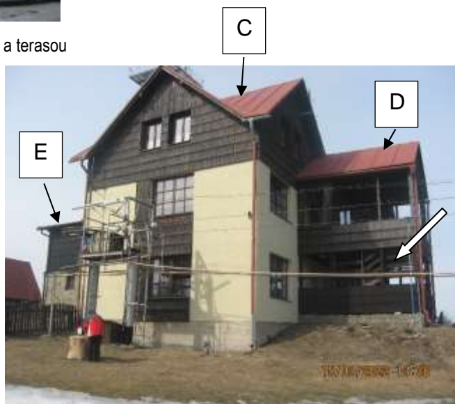
pohled na venkovní přístavbu zastřešeného schodiště k hlavnímu vstupu – ocelová knstrukce s dřevěným obkladem (2002 – 2003)
